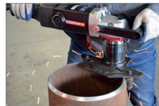
Anfasen von Rohren
