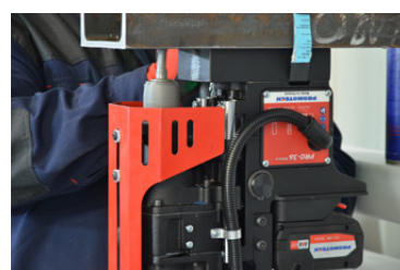
Lavorazioni in opera
