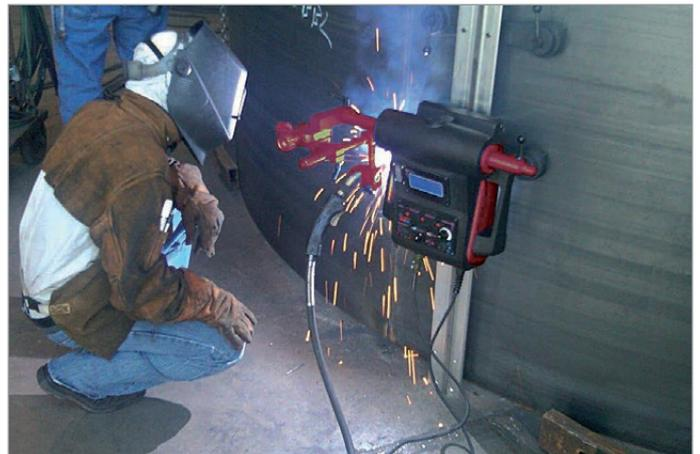
Rail Bull eignet sich für Arbeiten in horizontalen und vertikalen Positionen
