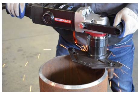
Anfasen von Rohren
