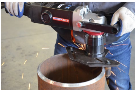
パイプ端面の開先加工
