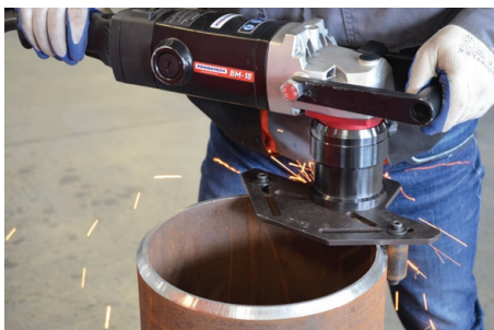
Afschuiven van buizen
