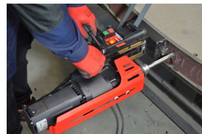
Foratura fuori posizione
